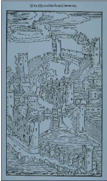
Ρόδος, σεισμός 3ης Μαΐου, 1481: Μεγάλες καταστροφές στην πόλη (ξυλόγλυπτο, 1496 στην Ulm, Γερμανία). (Πηγή: National Information Service for Earthquake Engineering, University of California, Berkeley, Kozak Collection, http://www.eerc.berkeley.edu/cgi-bin/kozak )
