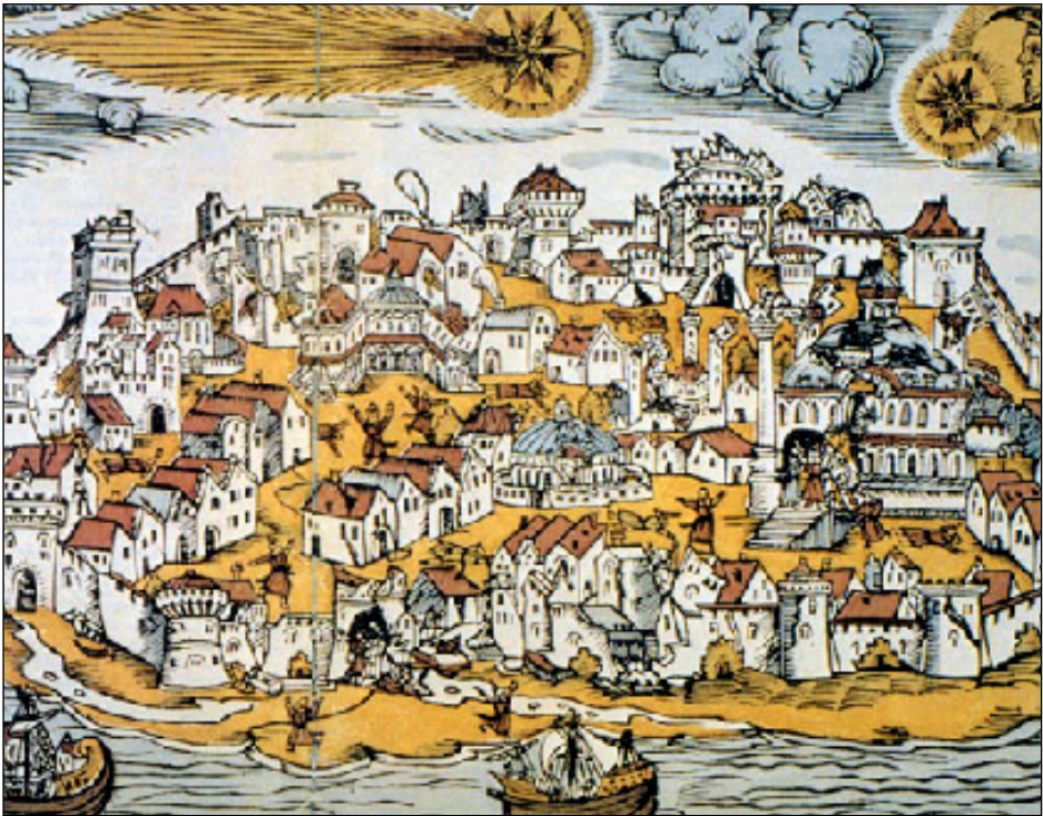
Σεισμός στην Κωνσταντινούπολη στις 10/5/1556 (Εγχρωμο ξυλόγλυπτο, Νυρεμβέργη, 1556). Το ξυλόγλυπτο απεικονίζει τις ζημιές στην πόλη και στον τρούλο της Αγίας Σοφίας. (Πηγή: National Information Service for Earthquake Engineering, University of California, Berkeley, Kozak Collection, http://www.eerc.berkeley.edu/cgi-bin/kozak )
