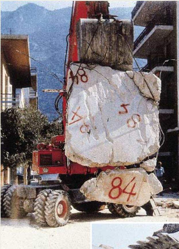
Φωτ. 9-10 Άρση τμήματος πλάκας (Φωτ. 9) και δοκού (Φωτ. 10) από εκσκα- φέα τσάπα. Έκκεντρη πρόσδεση ώστε ο κύριος σπλισμός του δομικού στοιχείου να πάρει κατα- κόρυφη διεύθυνση προς απο- φυγή τυχόν αναδίπλωσης του. (Έρευνα Αιτίων Κατάρρευσης, Λουτράκι 1981)
