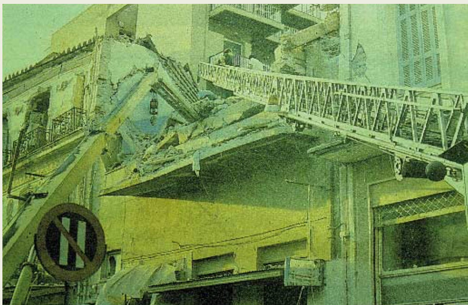
Φωτ. 16: Διάσωση παγιδευμένων από τριόροφο κτίριο στο οποίο κατέρρευσαν μόνο οι δύο ανώτεροι όροφοι. Προφανής ο κίνδυνος για τους παγιδευμένους και τους διασώστες από πιθανή κατάρρευση και του ισογείου σε ισχυρό μετασεισμό. Ο βραχίονας του γερανού αριστερά αποσκοπεί στην παρεμπόδιση της πτώσης του τοίχου του ημιερείπωμένου γειτονικού κτιρίου προς το μέρος των διασωστών. Διασώθηκαν δύο νεαρά άτομα με ελαφρά τραύματα επειδή είχαν την ετοιμότητα να καλυφθούν κάτω από έπιπλα. (Επιχείρηση Διάσωσης, Καλαμάτα 1986)
