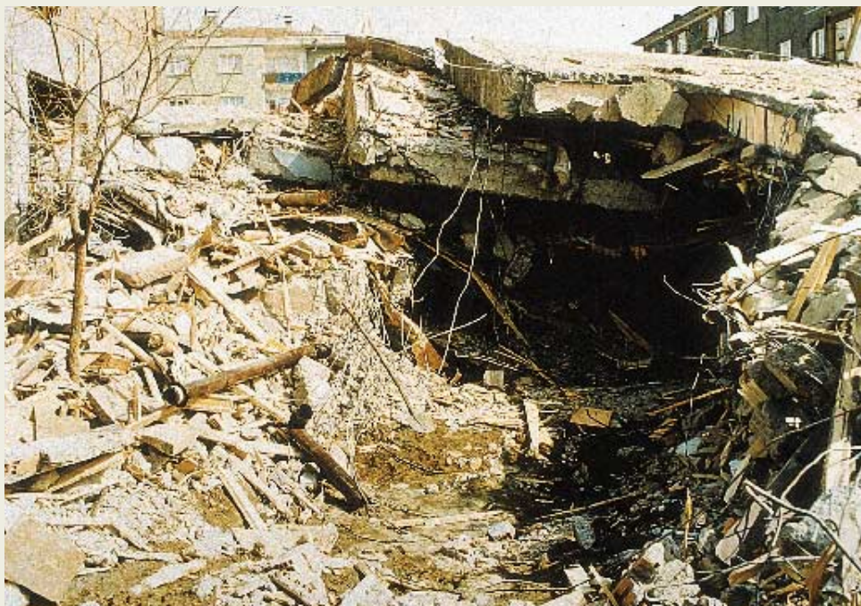
Φωτ. 15: Δημιουργία ευρέως μετώπου για διείσδυση στο ερείπιο με την απομάκρυνση μεγάλου τμήματος του κτιρίου στην πρόσοψη. (Μετωπική διείσδυση)
