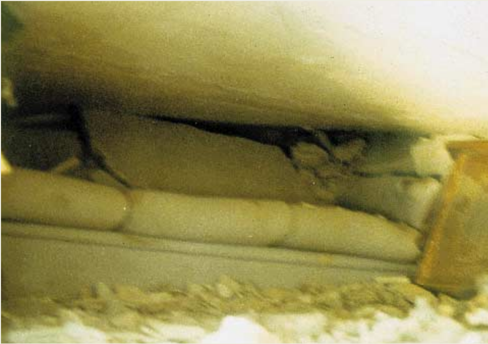
Φωτ. 7: Ο χώρος επιβίωσης και ο καναπές του καθιστικού πάνω στον οποίο βρισκόταν ξαπλωμένο το άτομο που απεγκλωβίστηκε χωρίς να έχει τραυματιστεί, 16 ώρες μετά τον σεισμό.
