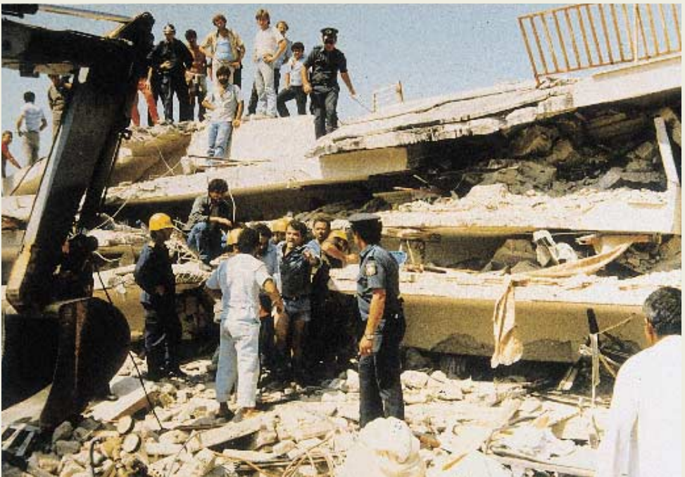
Φωτ. 5-6: Η πρώτη φάση της επιχείρησης σε εξέλιξη, δηλ. δημιουργία διόδου με τεμαχισμό του σκυροδέματος τμήματος δοκού και πλάκας στο δάπεδο του προς έρευνα ορόφου. Επικοινωνία με παγιδευμένο άτομο σε απόσταση 3-4m από την πρόσοψη. Στην δεύτερη φάση της επιχείρησης, διεξαγωγή οριζόντιας διεύθυνσης με τεμαχισμό και απομάκρυνση επίπλων και πλινθοδομών μέχρι την προσέγγιση και διάσωση του ατόμου. Χρόνος διεξαγωγής της επιχείρησης 3~3.5 ώρες. (Επιχείρηση Διάσωσης, Καλαμάτα 1986)
