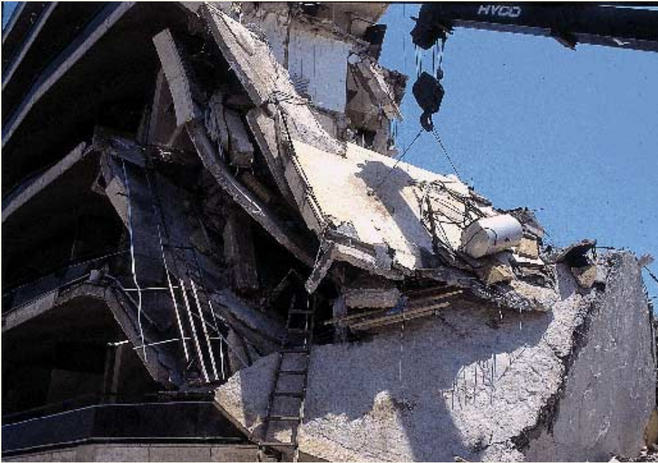
Φωτ. 11: Άρση με γερανό μεγάλου τμήματος πλάκας έντονα κεκλιμμένης λόγω της μερικής κατάρρευσης του κτιρίου. Αποκοπή του τμήματος από την υπόλοιπη πλάκα του ορόφου με το κόψιμο του οπλισμού κατά μήκος των γραμμών θραύσης της πλάκας. (Αίγιο 1995)
