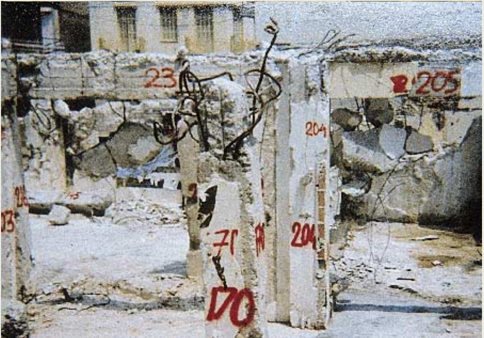
Φωτο 1: Δοκοί και υποστυλώματα του υπογείου. Διατήρηση της γεωμετρίας τους παρά την ολική κατάρρευση πάνω σ' αυτά έξι ορόφων. Εκτός από την ύπαρξη επαρκούς χώρου για επιβίωση, έχει δημιουργηθεί χώρος κατάλληλος και για εκκίνηση κατακόρυφης διεύθυνσης ανόδου. (Ερευνα αιτίων κατάρρευσης, Λουτράκι 1981)
