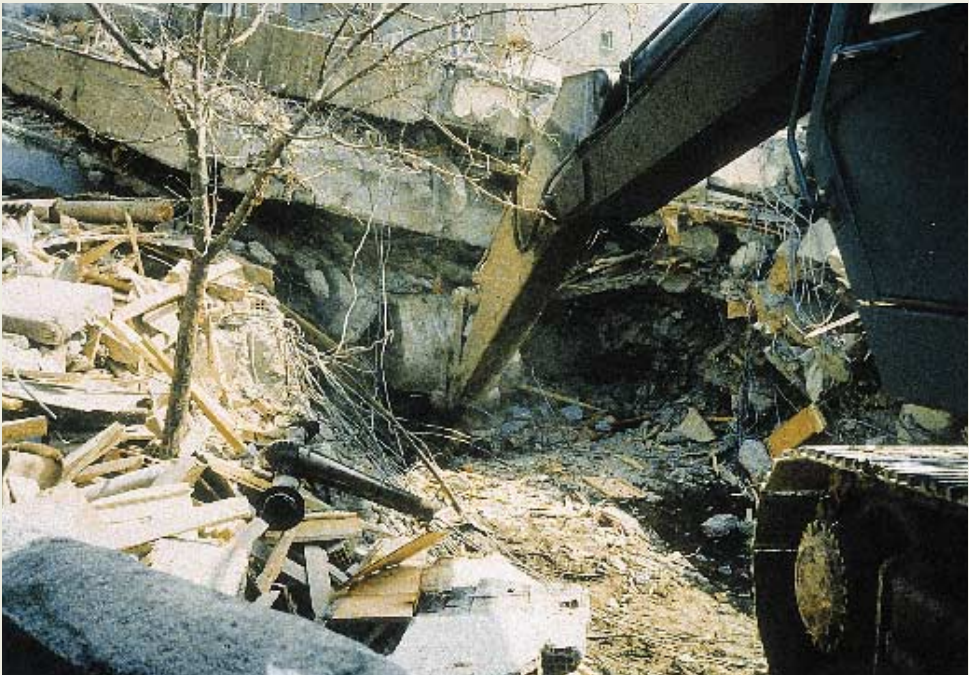
Φωτ. 14: Δημιουργία ευρέως μετώπου για διείσδυση στο ερείπιο με την απομάκρυνση μεγάλου τμήματος του κτιρίου στην πρόσοψη. (Μετωπική διείσδυση)
