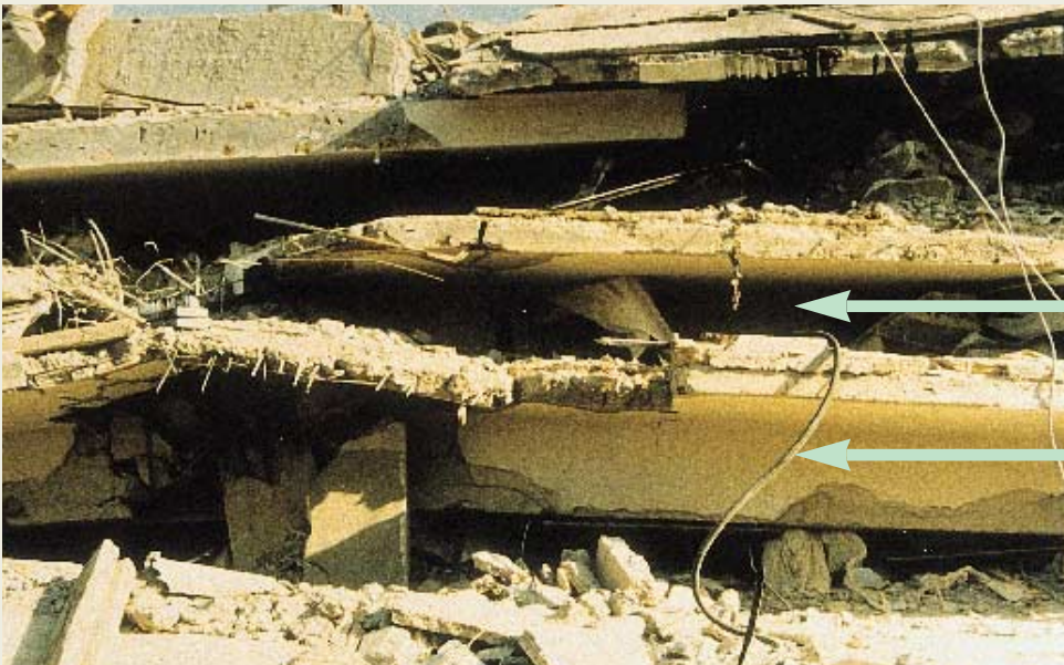
Φωτο 3: Επίπτωση υπνοδωματίου όπως αποκαλύφθηκε μετά την άρση της πλάκας οροφής. Το κομοδίνο και το προσκέφαλο του κρεβατιού έχουν υποστεί βλάβες από την πτώση τούβλων και επιχρισμάτων, έχουν όμως διατηρήσει το αρχικό τους ύψος. Αυτονόητη η χρησιμότητα της οδηνίας για κάλυψη σε πρηνή θέση κάτω από γερό έπιπλο.
