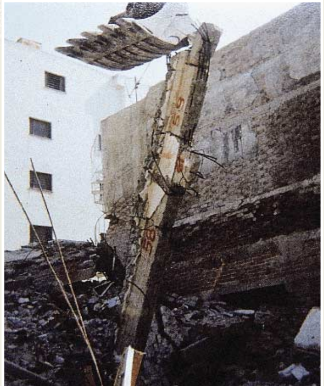
Φωτ. 9-10 Άρση τμήματος πλάκας (Φωτ. 9) και δοκού (Φωτ. 10) από εκσκα- φέα τσάπα. Έκκεντρη πρόσδεση ώστε ο κύριος σπλισμός του δομικού στοιχείου να πάρει κατα- κόρυφη διεύθυνση προς απο- φυγή τυχόν αναδίπλωσης του. (Έρευνα Αιτίων Κατάρρευσης, Λουτράκι 1981)
