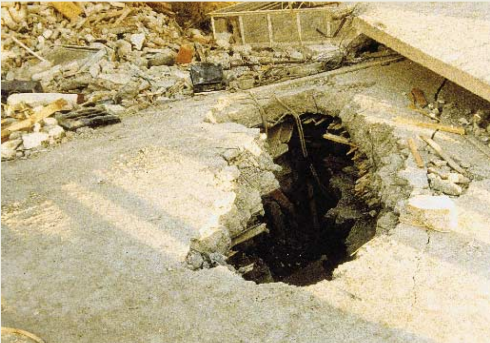
Φωτ. 12 : Άνοιγμα κατακόρυφης διείσδυσης καθόδου σε θέση που η πλάκα εμφανίζει μικρή κλίση προς το οριζόντιο επίπεδο αντίθετα με ότι συμβαίνει λίγο αριστερά. Διατηρήθηκαν δύο πλάκες και ακολούθησε οριζόντια διείσδυση με κλίση προς τα κάτω μέχρι το σημείο που υποδεικνύεται με το βέλος. Διασώθηκε βρέφος 24 ώρες μετά το σεισμό. (Διασωστική Επιχείρηση, Καλαμάτα 1986)
