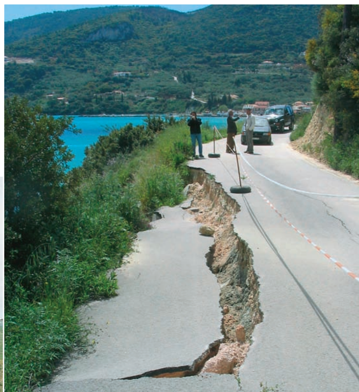
Εικ. 1.24. (δεξιά) Ζάκυνθος, σεισμός 2006 ( M=5,9 ). Καθίζηση του οδοστρώματος.
