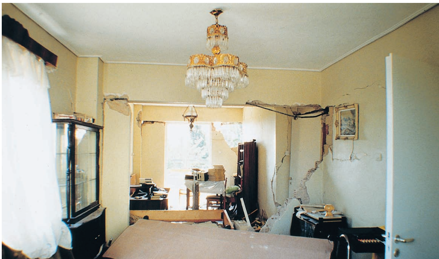
Εικ. 3.12, 3.13. Καλαμάτα, σεισμός 1986. Στα διαμερίσματα αυτά δεν είχε γίνει προσεισμικά άρση επικινδυνότητων και πρόβλεψη για κατάλληλη στήριξη των επίπλων με μεταλλικά ελάσματα στους τοίχους.
