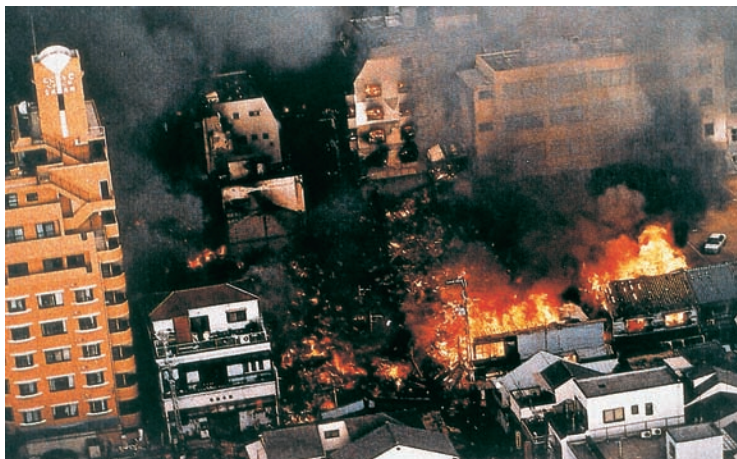
Εικ. 2.28. Hanshin - Kobe Ιαπωνία, σεισμός 1995. Οι φωτιές ξέσπασαν αμέσως μετά το σεισμό, λόγω διαρροών σε σωλήνες του αερίου για οικιακή χρήση. Έκαigan για 24 ώρες αναγκάζοντας τους επιζώντες να εγκαταλείψουν το κεντρικό Kobe αφήνοντας πίσω αγνοούμενους, συγγενείς και φίλους. Πολλά από τα ξύλινα σπίτια της πόλης καταστράφηκαν από τη φωτιά ενώ οι πυροσβέστες συνάντησαν μεγάλες δυσκολίες στην κατάσβεσή της εξαιτίας της έλλειψης νερού.
