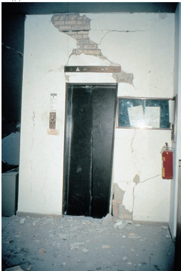
Εικ. 3.16. (αριστερά) Αίγιο, σεισμός 1995. Ο ανελκυστήρας είχε πάθει βλάβες. Η χρήση του την άμεση μετασεισμική περίοδο μπορούσε να προκαλέσει τον εγκλωβισμό ατόμων.
