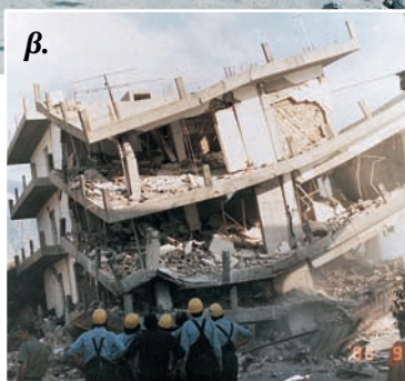
Εικ. 2.5α,β. Καλαμάτα, σεισμός 1986. 20 νεκροί, 80 τραυματίες. Κατάρρευση 4 πολυκατοικιών στην πόλη της Καλαμάτας. Η ένταση του σεισμού στην πλειόσειστη περιοχή ήταν VIII της κλίμακας Mercalli.
