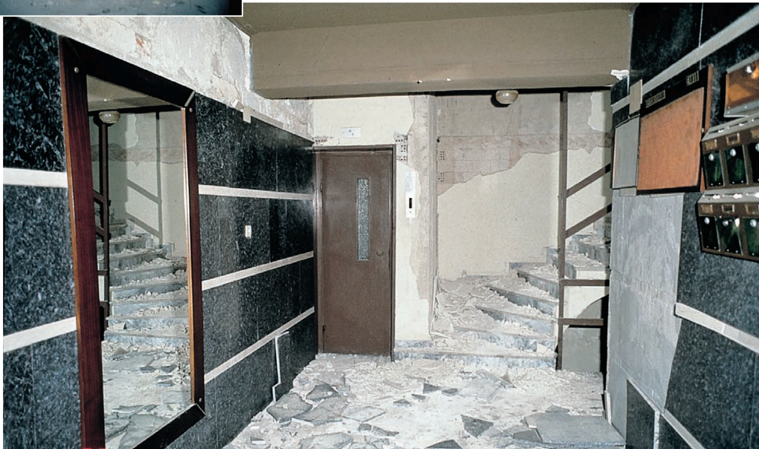
Εικ. 3.17. (κάτω) Καλαμάτα, σεισμός 1986. Οι ένοικοι δε χρησιμοποίησαν τον ανελκυστήρα για την έξοδο τους από την πολυκατοικία μετά το τέλος της σεισμικής δόνησης. Ο κίνδυνος όμως παραμένει και στις σκάλες, από τους πεσμένους σοβάδες, τα σπασμένα τζάμια και μάρμαρα.
