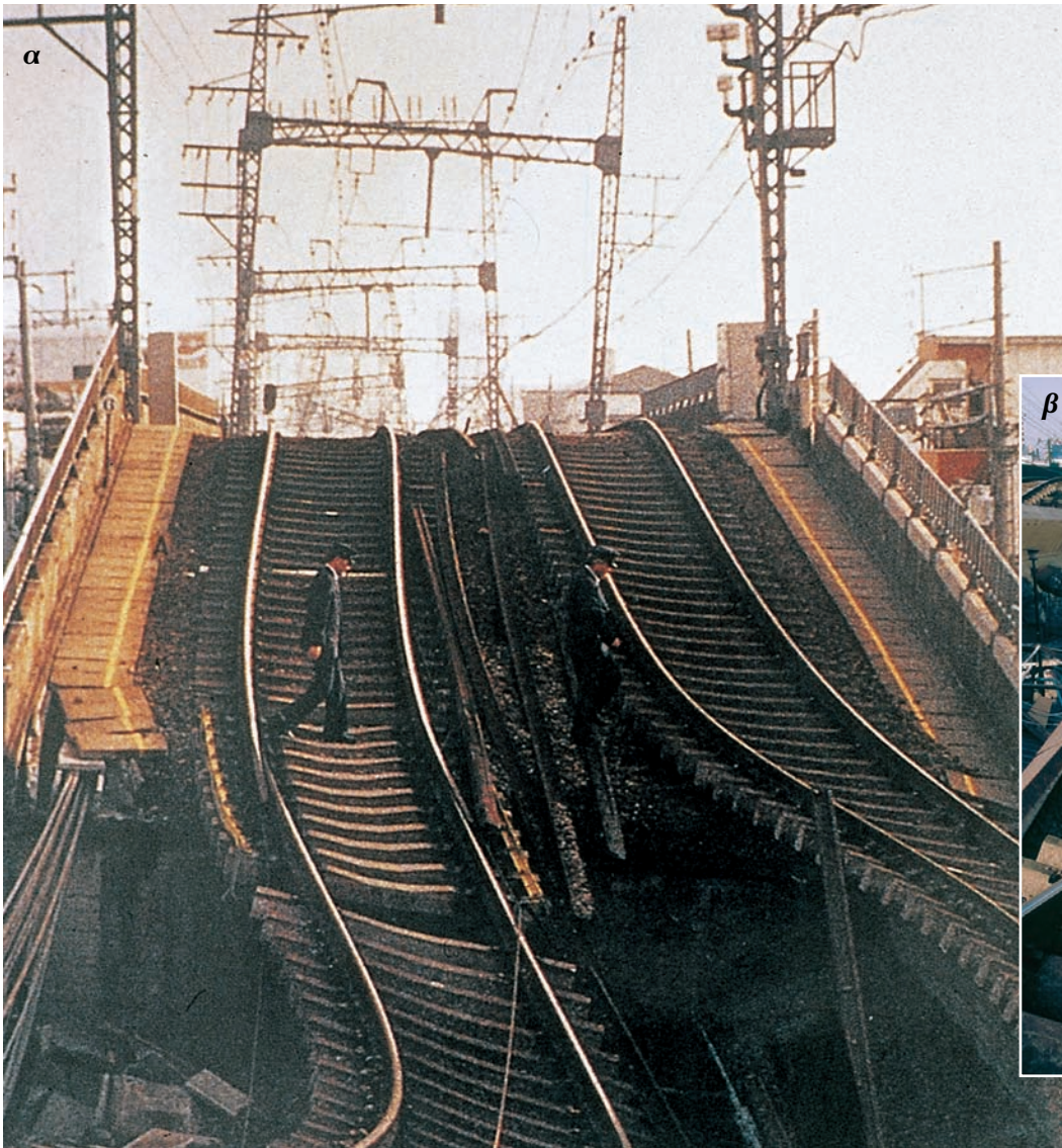
Εικ. 2.18α,β. Hanshin - Kobe Ιαπωνία, σεισμός 1995. Το σιδηρο- δρομικό δίκτυο έπαθε σοβαρές ζημιές και έμεινε εκτός λειτουργίας για έξι μήνες περίπου.
